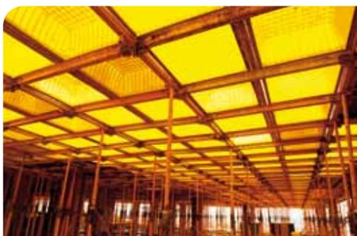
**Cubeta** – A cubeta é uma forma de plástico para moldar concreto. Em nossas obras, utilizamos 30% do volume de formas com esse material, cujo reaproveitamento é cinco vezes maior do que a forma de madeira, mais comumente utilizada.
