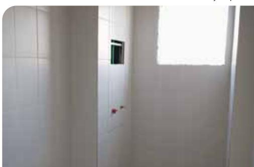
**Shaft visitável e tubulações aparentes** – a instalação hidráulica de todos os nossos empreendimentos é feita de modo aparente, com uma abertura de PVC que dá acesso a ela. Com isso, em casos de manutenção ou reforma, não é necessário que o morador quebre a parede.
